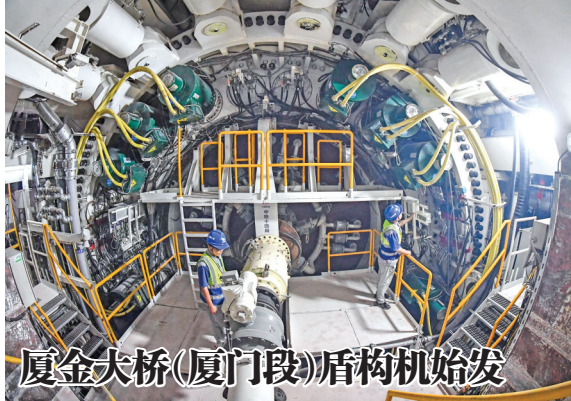
6月8日,“厦金号”盾构机在厦门市思明区环岛东路始发,标志着由厦门路桥建设集团有限公司建设、中铁十四局参与施工的厦金大桥(厦门段)环岛路隧道正式进入盾构掘进施工阶段。
